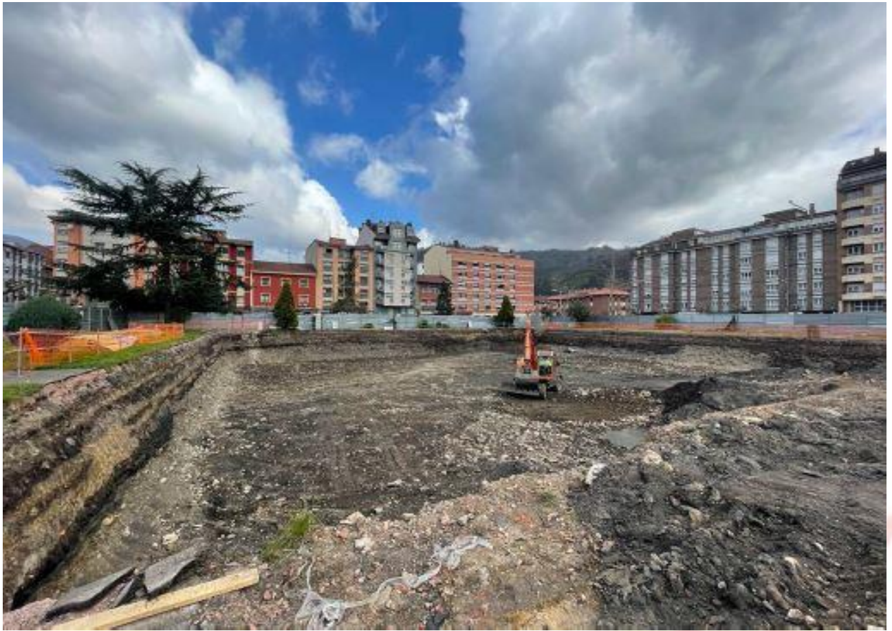
Inicio de las obras del nuevo acuartelamiento de Mieres.
